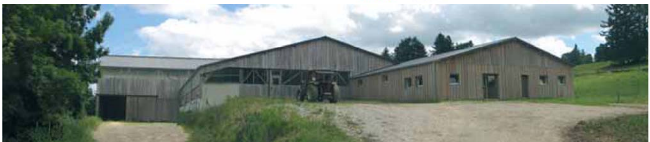
Mise à profit du dénivelé dans la construction
